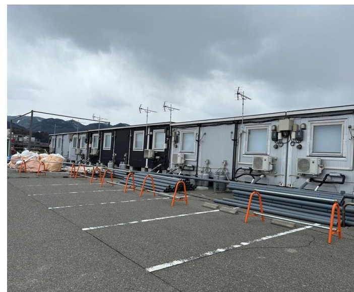
仮設住宅建設地(マリンタウン)
