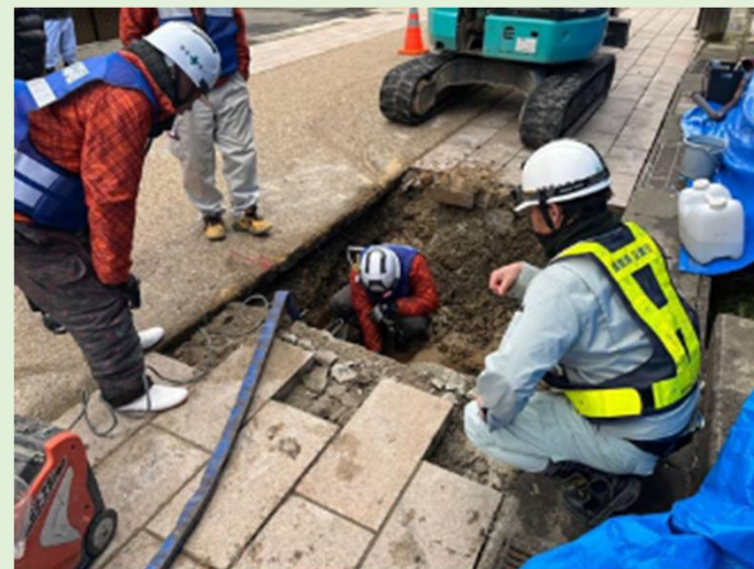
上水道復旧支援(能登町内)
