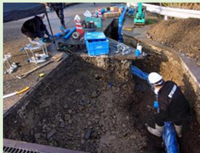
水道管復旧確認(能登町内)
